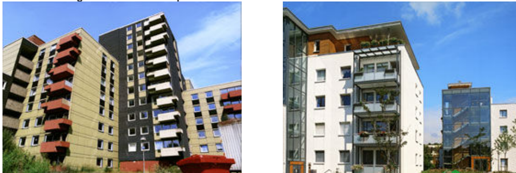
Abb. 12: Wohngebäude im Schillerpark vor und nach dem Umbau
